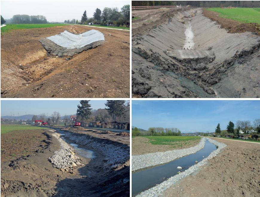
**Abbildung 3:** Bauphasen des neu angelegten Abschnitts des „Alten Teiches“ auf Strecke 4 (Oktober 2010, November 2010 und März 2011) und Strecke 3 (oben rechts, November 2010). – **Figure 3.** Steps in the construction of the newly created “Alter Teich” on section 4 (October 2010, November 2010 and March 2011) and section 3 (upper right, November 2010).
