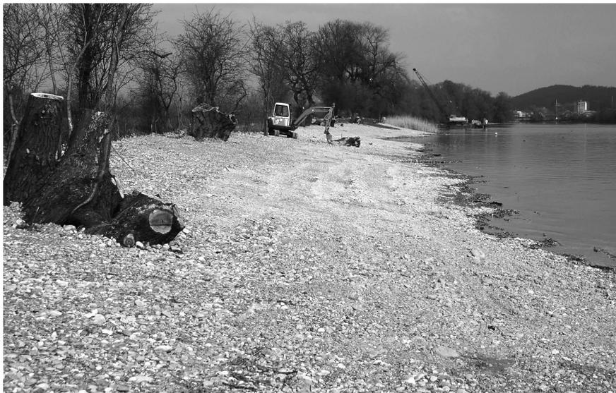
Abbildung 1: Flachufer der Aare bei Selzach, Kanton Solothurn, Schweiz, während der Umgestaltung (27.03.2007). – Figure 1: Shallow bank of the river Aare near Selzach, Canton of Solothurn, Switzerland, during revitalization works (27-iii-2007). Photo: KE
