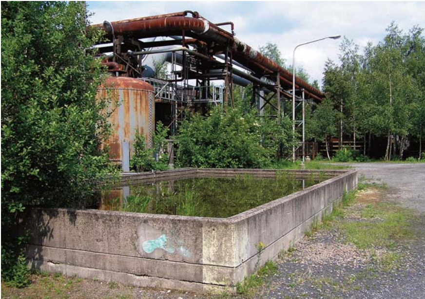
Abbildung 6: Klärschlammbecken auf der Kokerei Hansa in Dortmund: Becken mit gut ausgeprägter Vegetation (02.06.2007). — Figure 6: Pool for industrial sewage sludge in the 'Kokerei Hansa', Dortmund, North Rhine Westphalia, Germany: Pool with well-developed vegetation (02-vi-2007).
