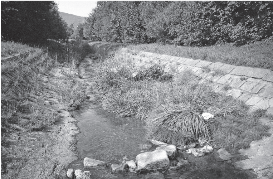
Abbildung 3: Der Höllmühlbach war im gesamten untersuchten Bereich reguliert und enthielt kaum feines bzw. loses Sohlsubstrat. Linz, Österreich (10.08.2000). – Figure 3. The 'Höllmühlbach' was regulated in the investigated section and fine sediments were only found at very few spots in the river bed. Linz, Austria (10-viii-2000).
